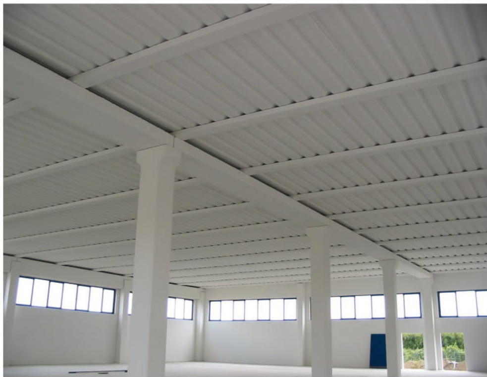
VISTA INTERNA DI INSIEME CON APPOGGIO CENTRALE SU ARCHITRAVE IN SPESSORE
