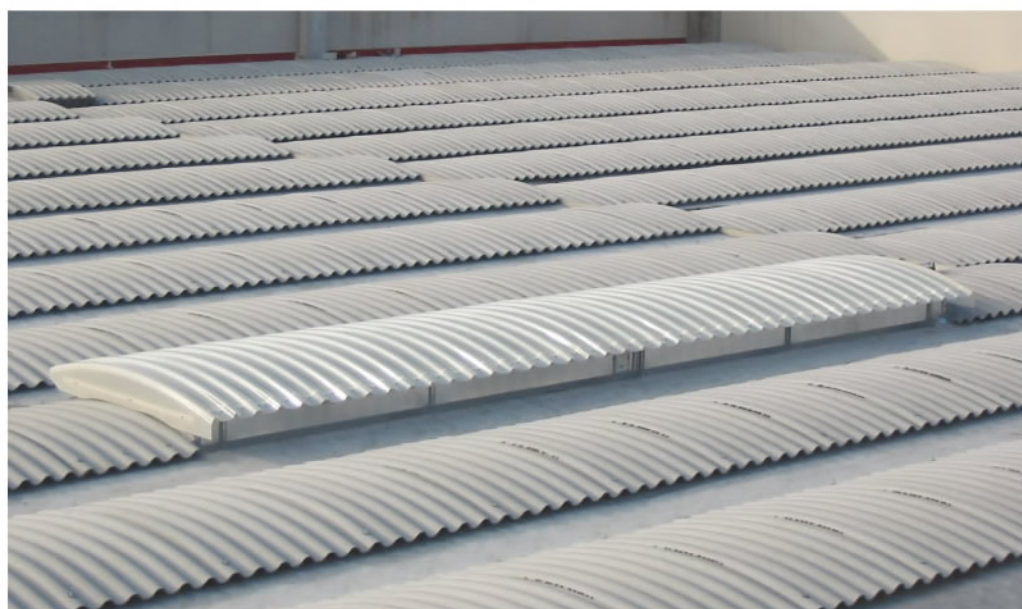
VISTA ESTERNA DI LUCERNARIO ZENITALE
