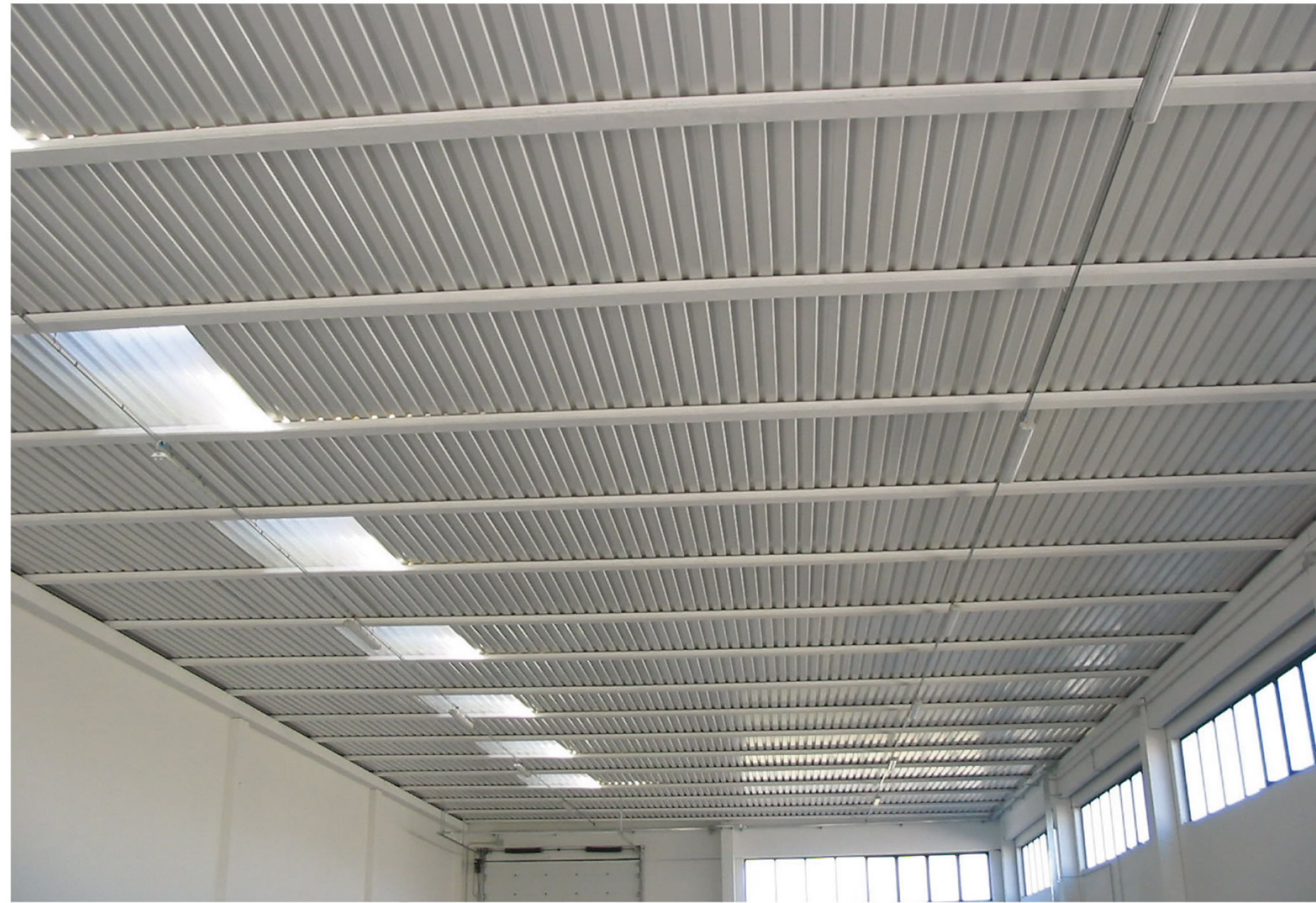
VISTA INTERNA DI INSIEME CON LUCERNARI FISSI
