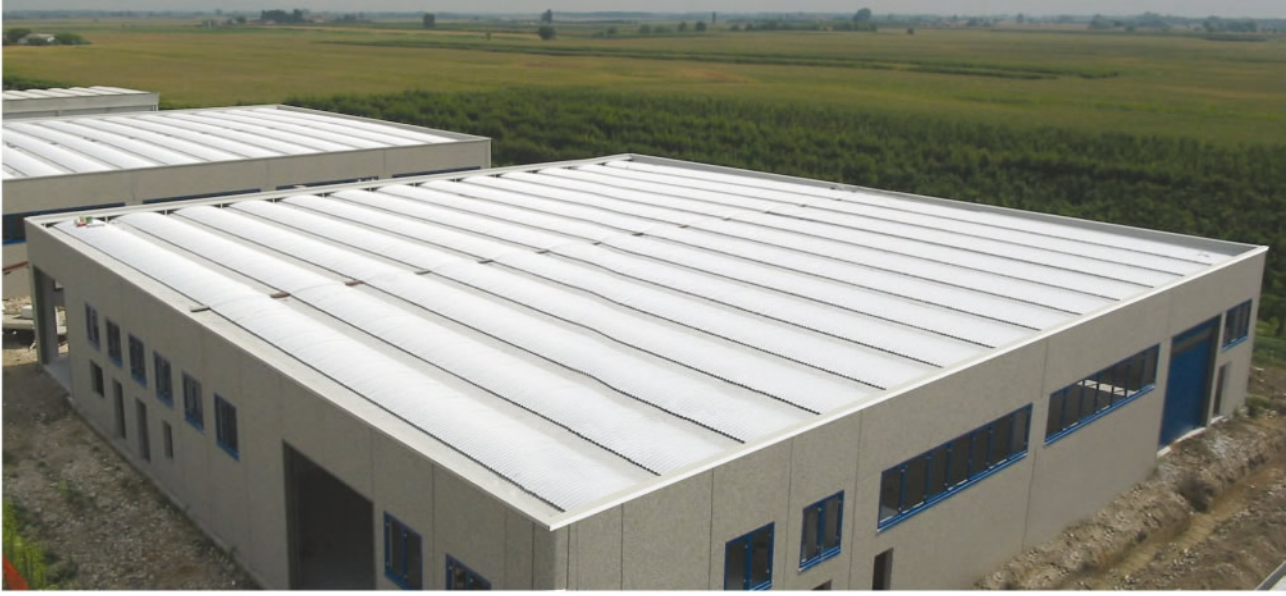
VISTA ESTERNA DELLA COPERTURA CON LASTRA IN ALLUMINIO
