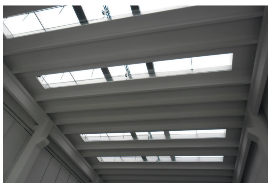
COPERTURA DOPPIO T CON LUCERNAI ZENITALI APRIBILI ED EVACUATORI DI FUMO E CALORE
