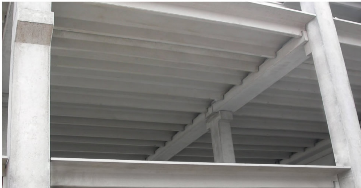
PARTICOLARI NODO PILASTRO- ARCHI TRAVE TEGOLI DOPPIO T SU STRUTTURE PLURIPIANO
