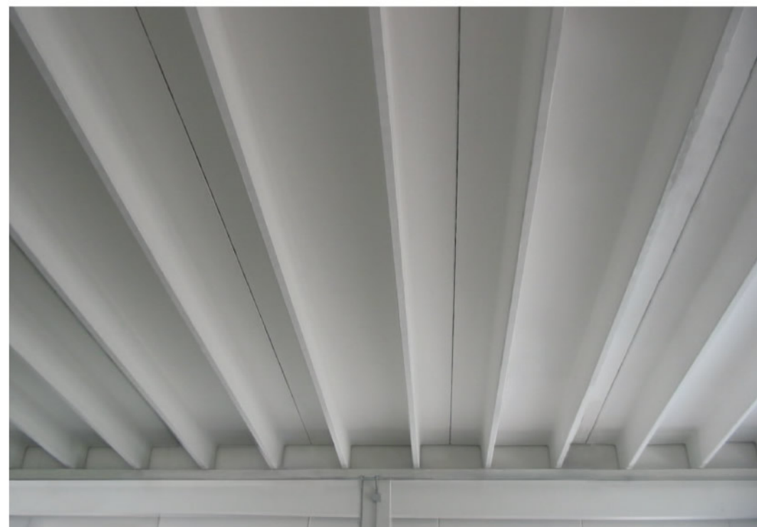
COPERTURA DOPPIO T CON TEGOLI ACCOSTATI
