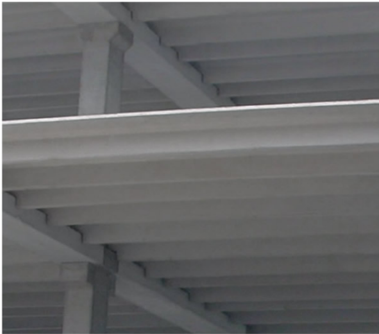
PARTICOLARI NODO PILASTRO- ARCHI TRAVE TEGOLI DOPPIO T SU STRUTTURE PLURIPIANO
